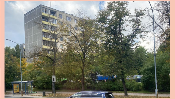
fig.7 旧ソ連時代に建てられた集合住宅
